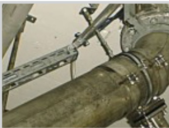
Vibradores de Impacto de Impacto de intervalo en tubo de transferencia.
